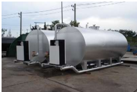
ภาพที่ 7.2.3-1 ตัวอย่างการเทพื้นคอนกรีตในบริเวณที่อาจเกิดการรั่วไหลของน้ำมันและไขมัน
